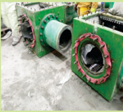
Retiro de Spool sacrificio de Válvulas Dardo.
