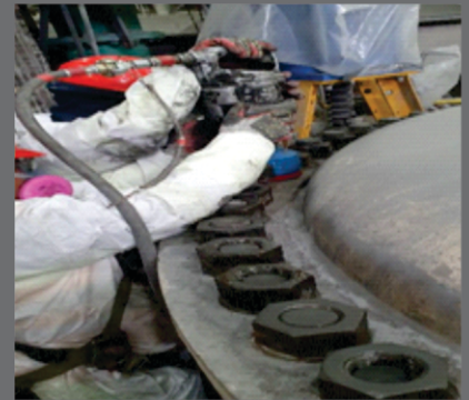
Ajuste de pernos de tapa superior del nido de ciclones
